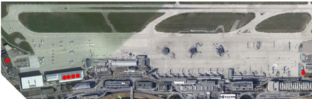
Figure 6: position des émissions chauffage en 2012. En 2030, le point en bas à droite (chaufferie actuelle) disparaît.
