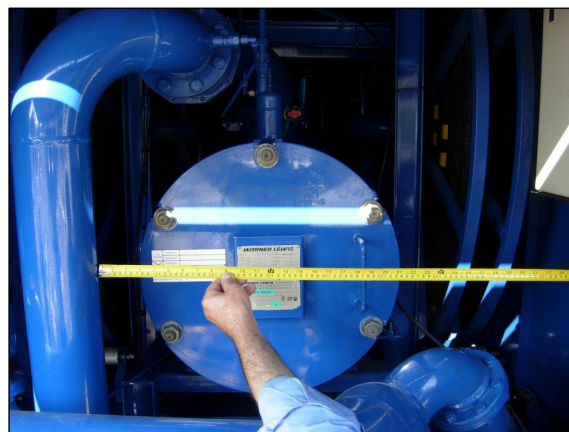
Figura 3 Esempio di impossibilità di riequipaggiamento a causa della mancanza di spazio [AFF 2018, EI / JIG, End of the Filter Monitor]
