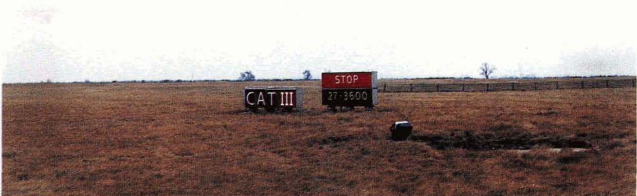
Figure A-4. — Panneau de point d'attente de catégorie III et panneau d'arrêt installés côte à côte
