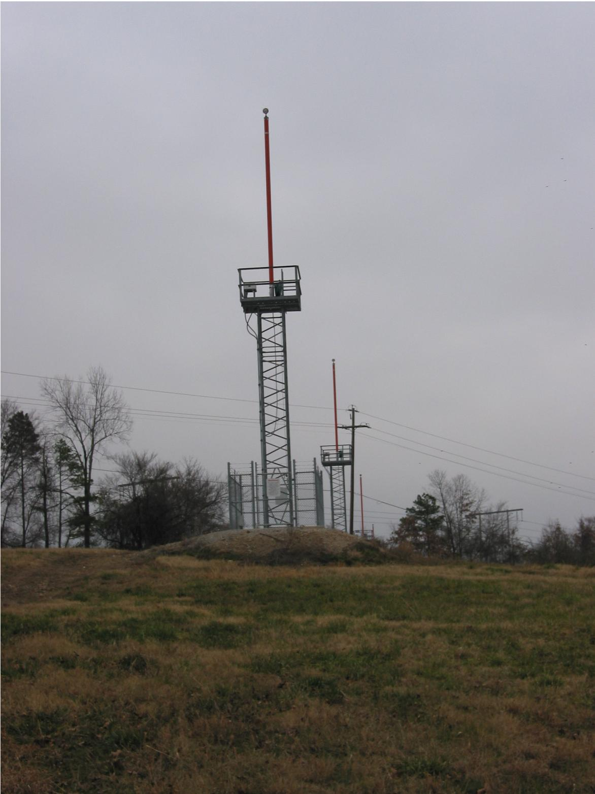
**Figure 4-7. Mâts tubulaires en fibre de verre sur structure rigide**
