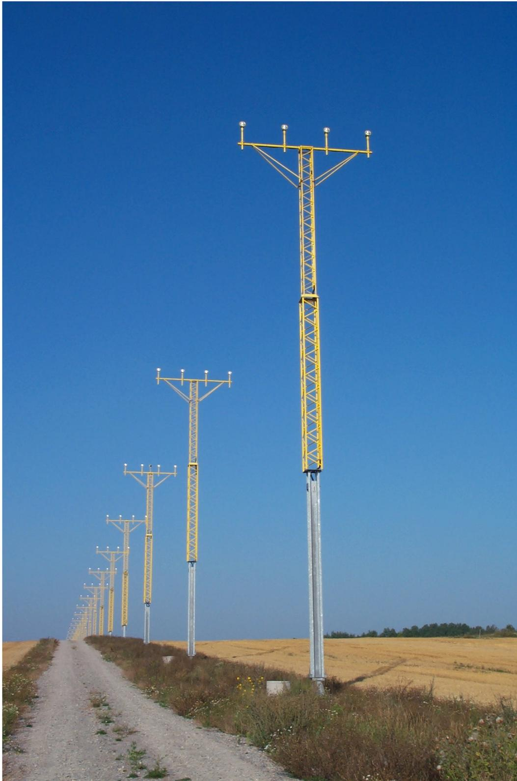
Figure 4-8. Mâts de balisage lumineux d'approche en fibre de verre sur montants rigides
