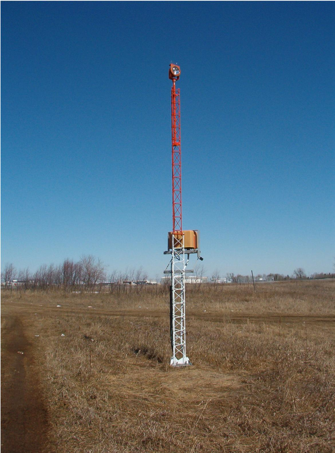
Figure 4-5. Gros plan d'un mât de balisage lumineux d'approche — structures d'aluminium en treillis
