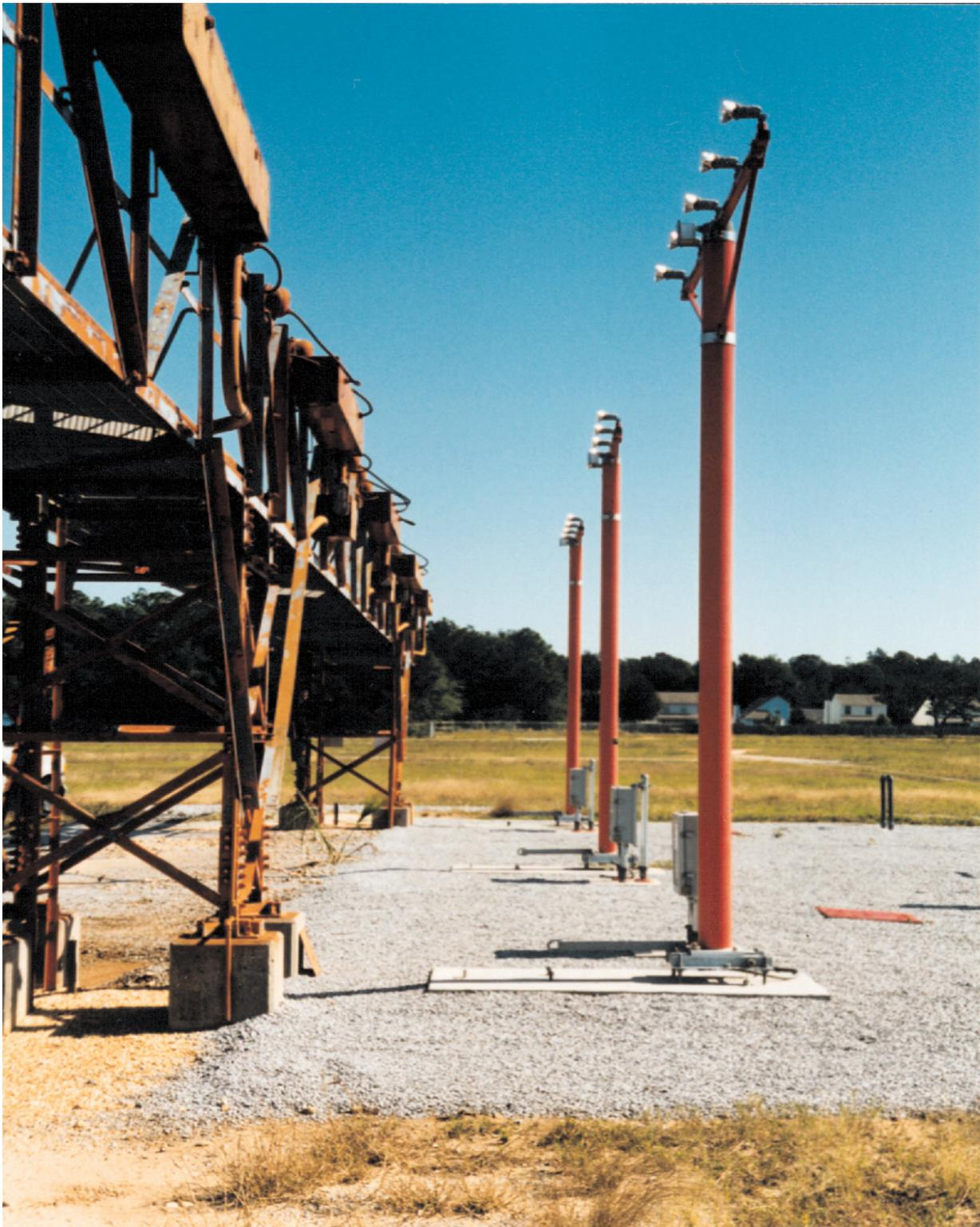
**Figure 4-6. Station de balisage lumineux d'approche de conception rigide (à gauche) remplacée par de nouvelles structures frangibles (à droite)**
