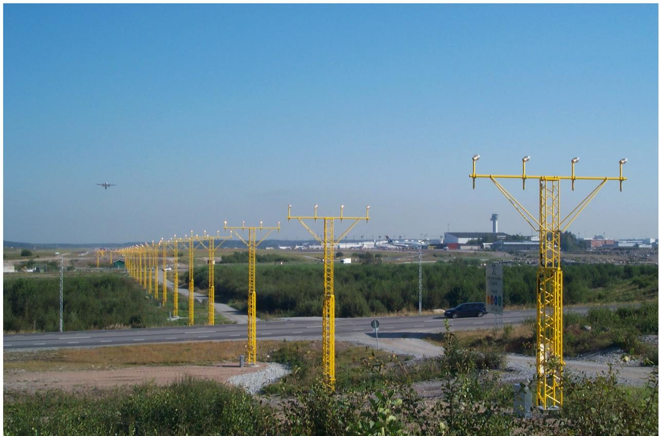
Figure 4-2. Mâts de balisage lumineux d'approche — structures de fibre de verre en treillis
