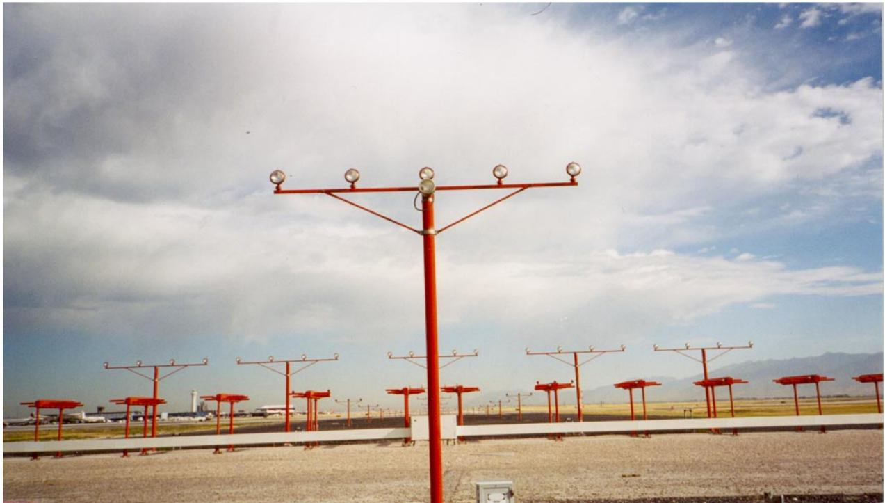
**Figure 4-3. Mâts de balisage lumineux d'approche — mâts tubulaires en fibre de verre**
