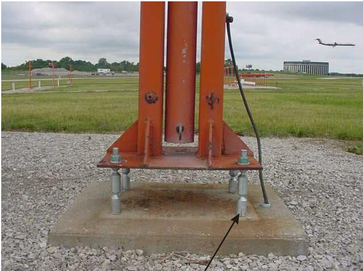
**Figure 4-1. Boulon fusible**
