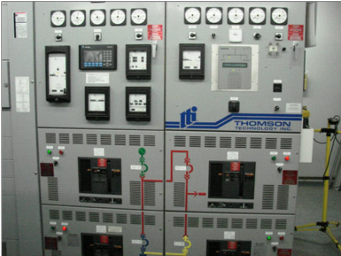
Figure 3-8. Tableau de transfert d'alimentation (source : Aéroport international de Toronto)
