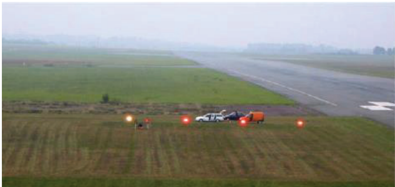
Figure 8-16. PAPI vu depuis une nacelle Photo : STAC, France
