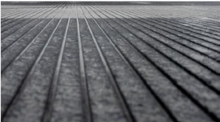
**Figure A6-4. Rainurage d'une surface en asphalte
