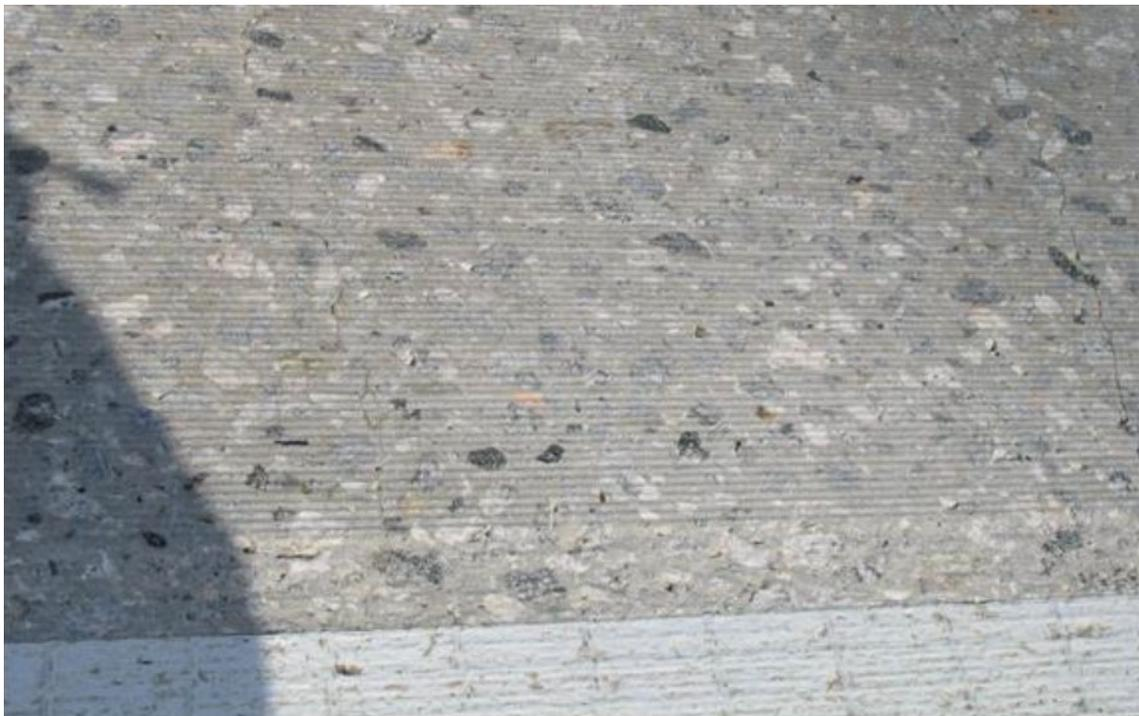
**Figure A6-7. Béton de ciment Portland existant avant et après le meulage**
