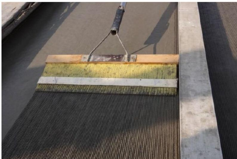
**Figure A6-6. Revêtement neuf texturé à l'aide d'un peigne métallique**
